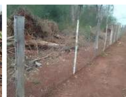
Protección de chacos
